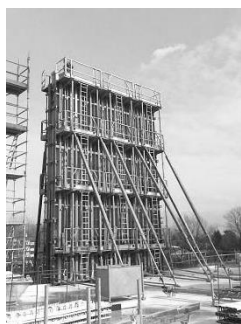
Fig. 1. Béton coulé entre deux coffrages.
